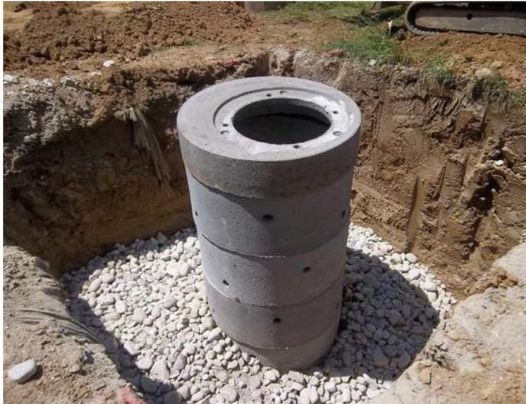
Figure 6 : Exemples de puits d'infiltration
