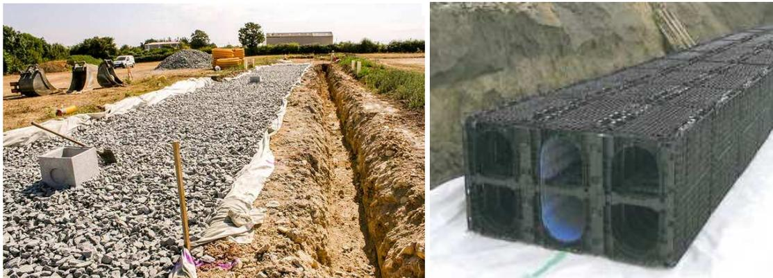
Figure 4 : Exemples de structures réservoirs enterrés (matériau poreux et structures alvéolaires)
