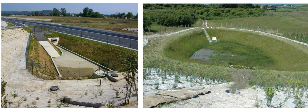
Figure 9 : Exemples de bassins de rétention et/ou infiltration
